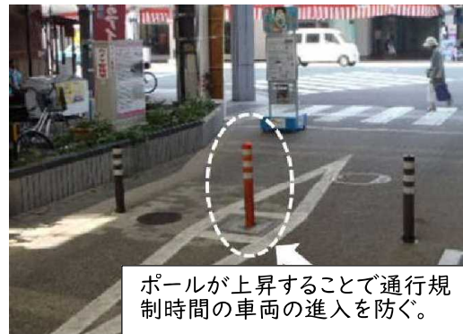
図：新潟市ふるまちモールに設置されたライジングボラード
