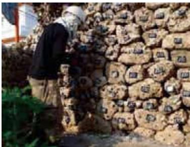
一番下の基礎になる石（根石）が歪んでいと再び崩落を起こすため、石積み一度全て解体する。その後、再び石を元の位置に正確に戻すため、大小全ての石に番号を貼り付けていく。
