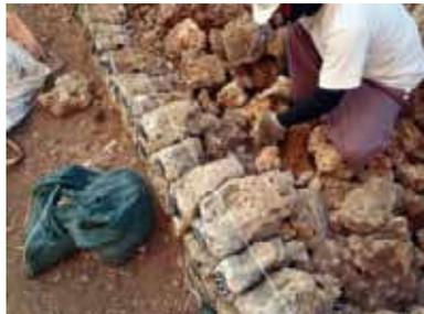
解体時の記録や測量をもとに積み直す。なるべく元の石材を再利用するが、欠損している箇所は同じ材質の石（祥雲寺は琉球石灰岩）で補填する。
