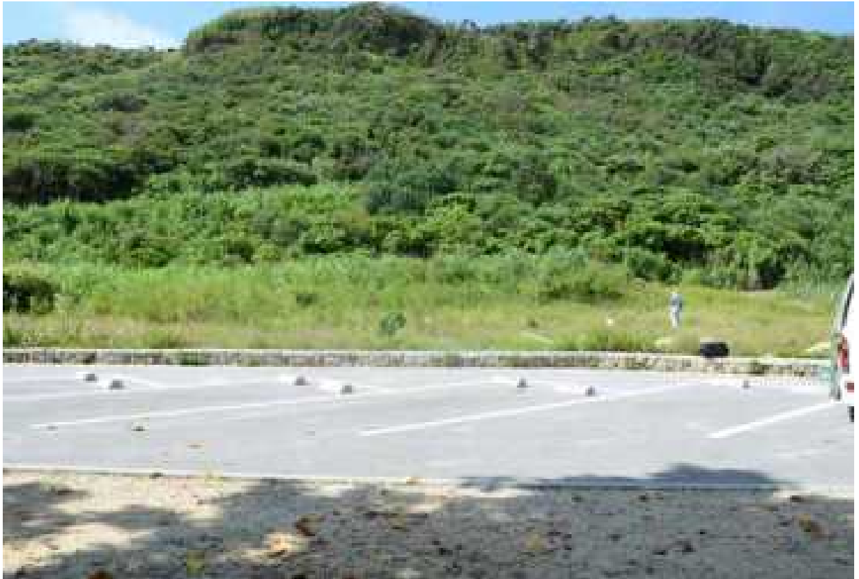
図版 16 調査区遠景（北側駐車場より）
