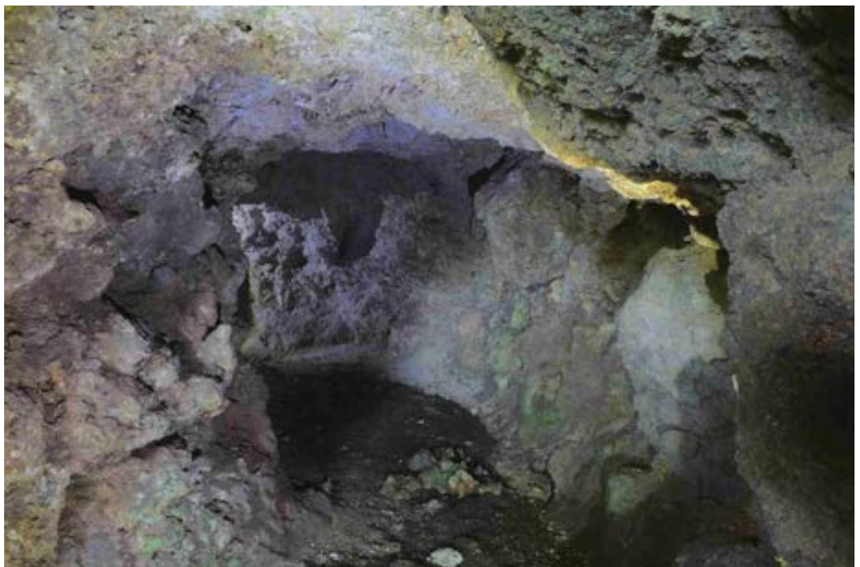
写真 41 壕 1・壕口 2 を内部より望む
