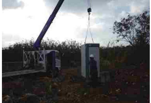
写真 12 簡易トイレ設置作業風景
