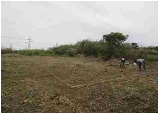
写真3 A地区調査区設定状況
