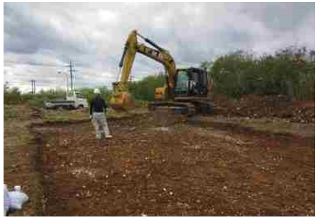
写真4 A地区表土掘削作業風景
