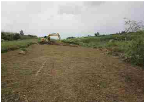
写真7 B地区重機掘削作業風景
