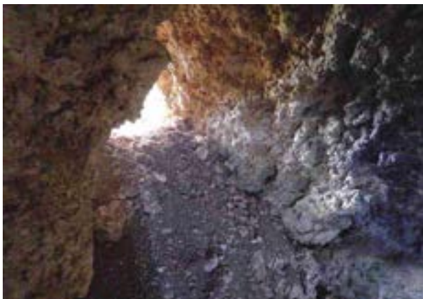
写真51 壕2・壕口（壕内部より）
