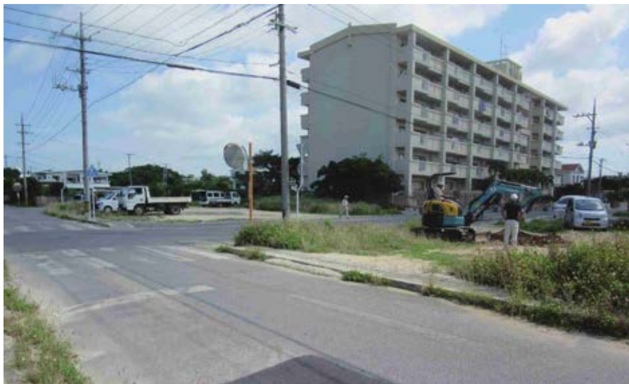
写真 19 調査地近景（右側の重機で掘削を行っているのが東地区で、道路をはさんで西地区）
