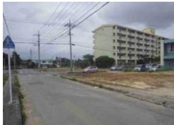
写真 9 調査完了後（埋め戻し状況・南より）
