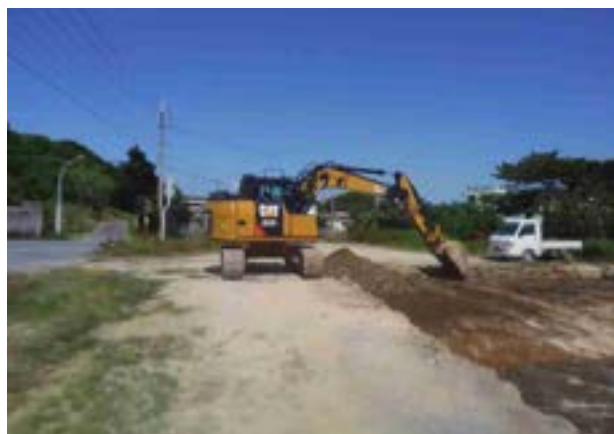
写真3 重機掘削作業風景
