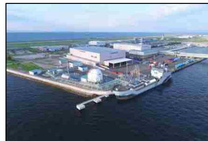
神戸港水素荷揚基地 Hy touch 神戸 2,500m 3 球形液化水素貯蔵タンク 敷面積：77,000m 2
