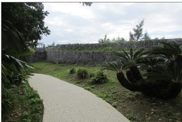
写真. 4 首里杜ぐすく (北西方向から)
