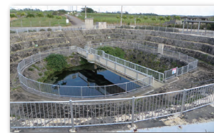
水位水質監視施設
