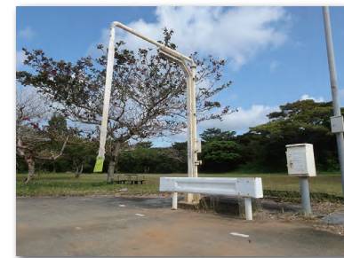
火災時は防火用水にもなるⅢ型給水所
