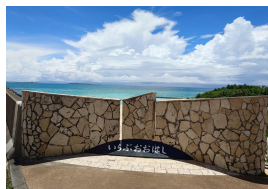
伊良部大橋の伊良部島側
